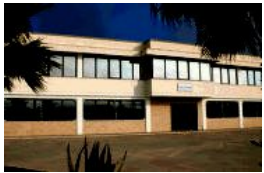
Processi Speciali Site
